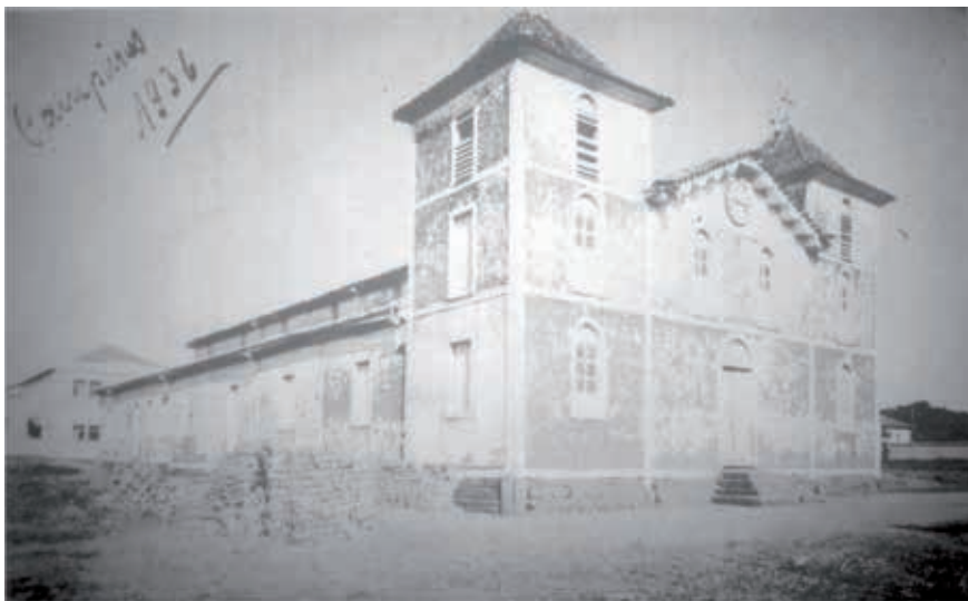
Igreja Matriz de Campinas em 1936. Nota-se que os beirais dos telhados das naves laterais são assentes em cachorros de madeira e as janelas das mesmas naves são possuem vergas retas. Ao lado uma pilha de tijolos para reforma que se dará naquele ano, dotando a Matriz de platibandas e janelas arqueadas nas naves laterais. Fotografia do livro Notícias Históricas do Bairro de Campinas, de Itaney Francisco Campos.
