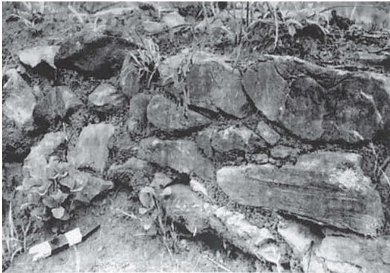
Setor 2 – Detalhe de muro de pedra
