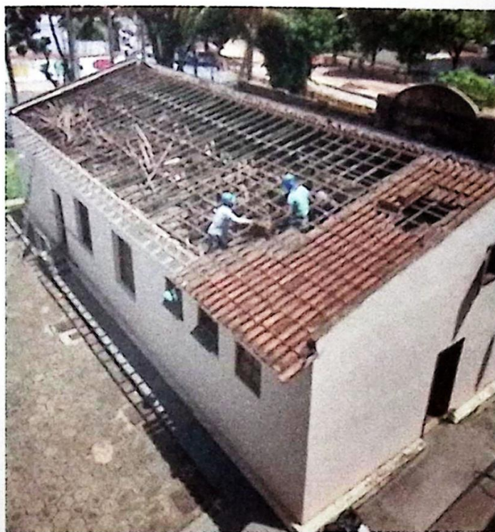
Figura 4. Obras de restauração da Casa Rosada de Goiânia
