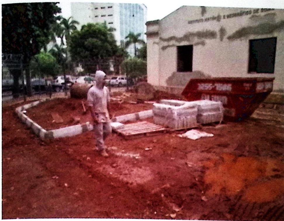
Figura 3. Obras de restauração da Casa Rosada de Goiânia
