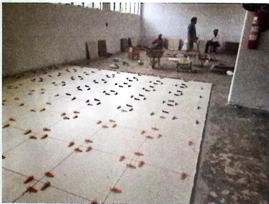
Figura 9. Reforma do primeiro andar
