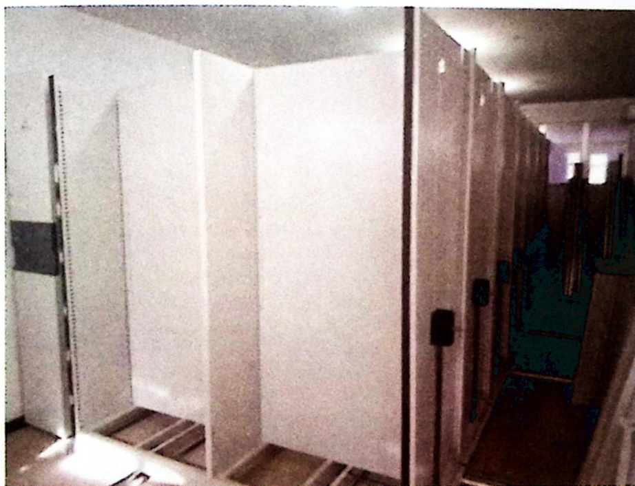
Figura 16. Montagem de 28 módulos de estantes deslizantes
