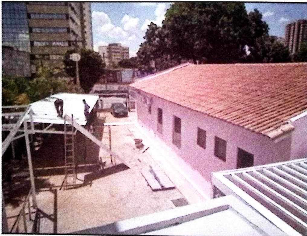
Figura 5. Obras de restauração da Casa Rosada de Goiânia
